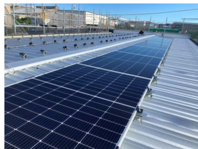
太陽光発電システム 施工現場
