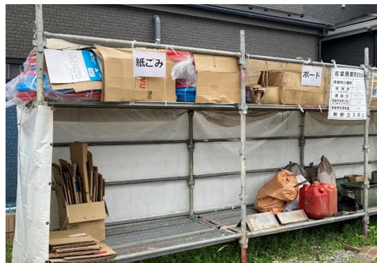
産業廃棄物保管場所 施工現場写真
