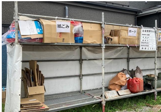
産業廃棄物保管場所 施工現場写真
