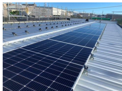
太陽光発電システム 施工現場
