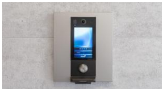
置き配システム機能付集合玄関機 現場写真
